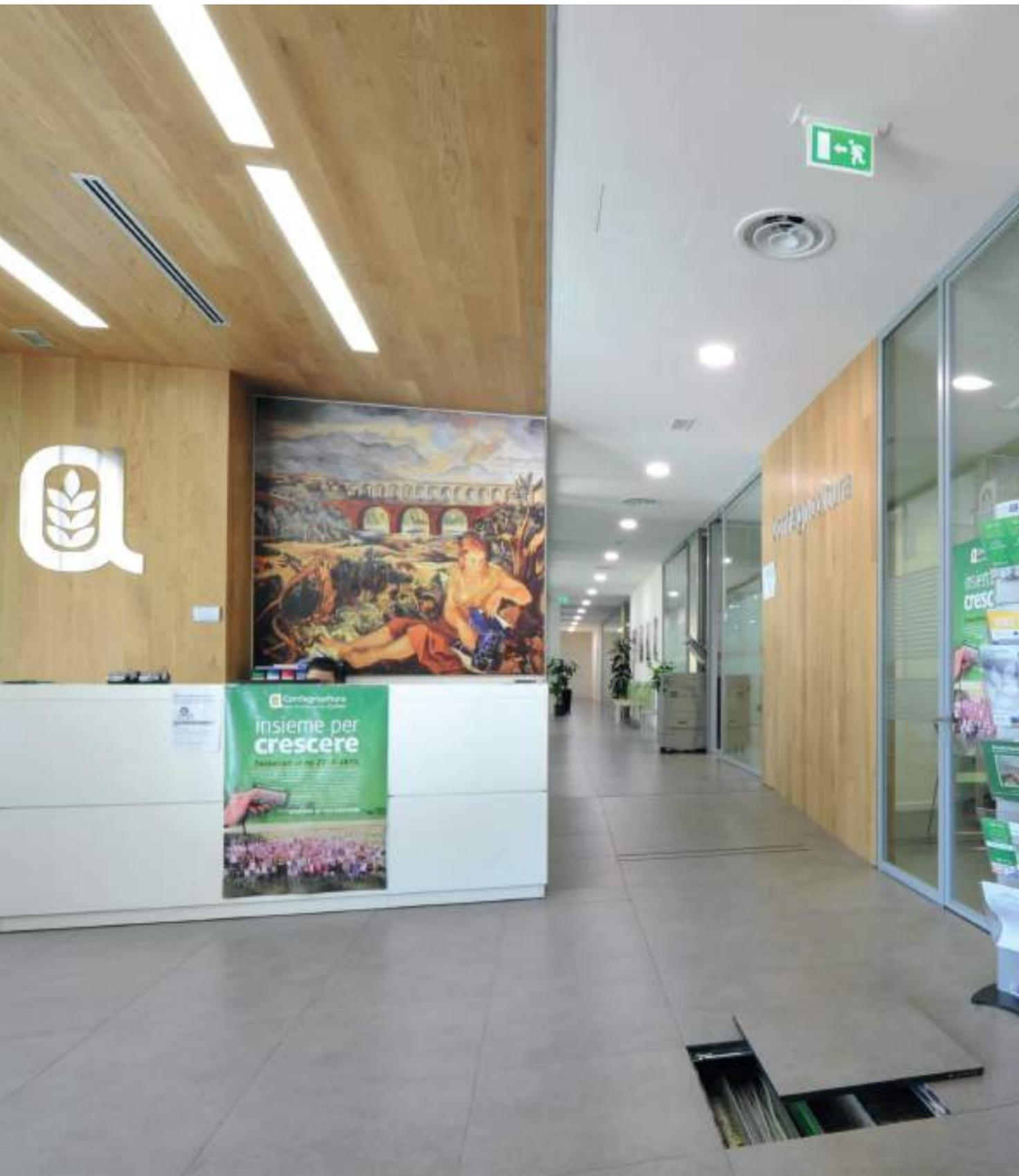
Uffici realizzati con pannello **Monotec** con finitura in gres naturale 600x600mm
