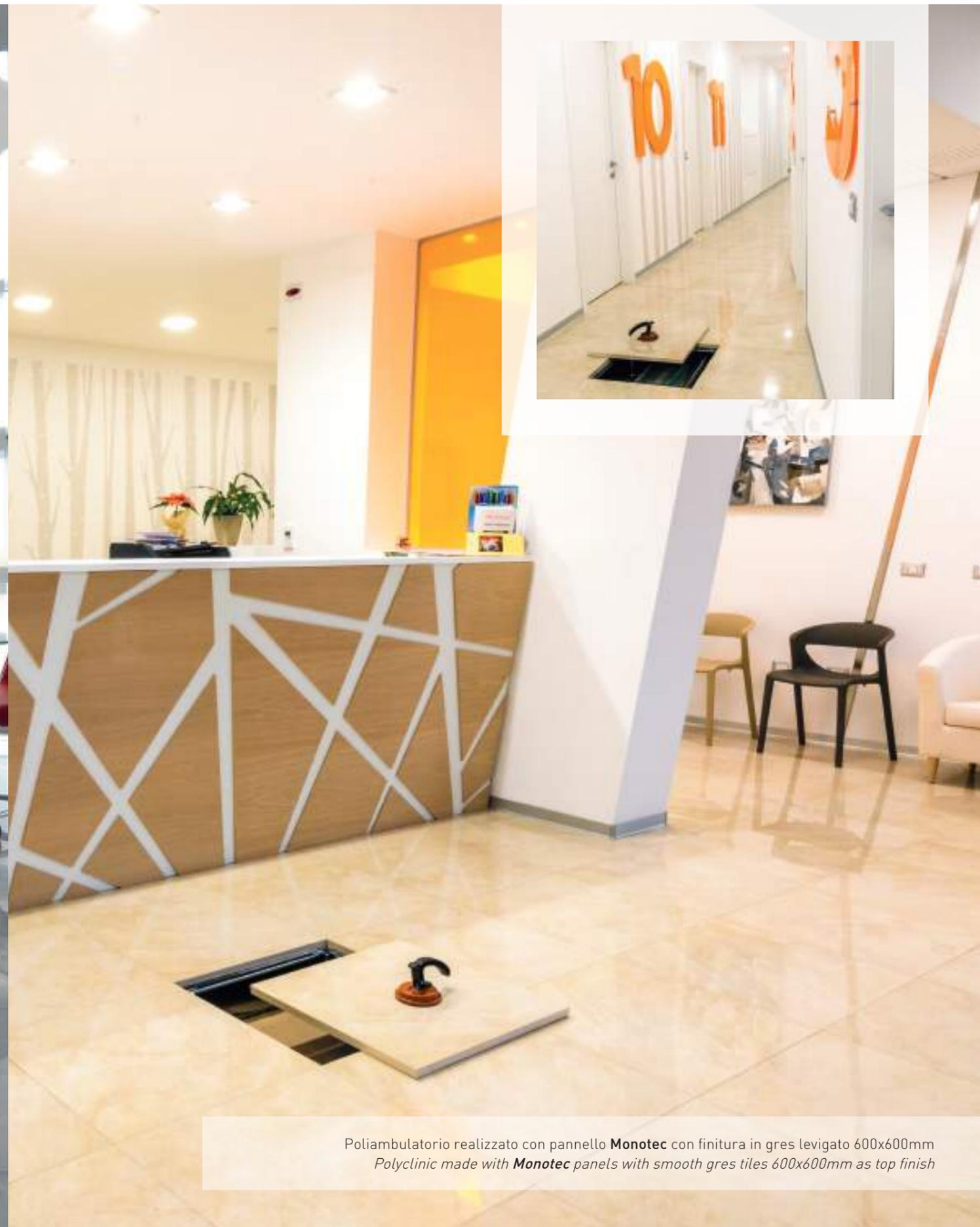
Poliambulatorio realizzato con pannello **Monotec** con finitura in gres levigato 600x600mm
