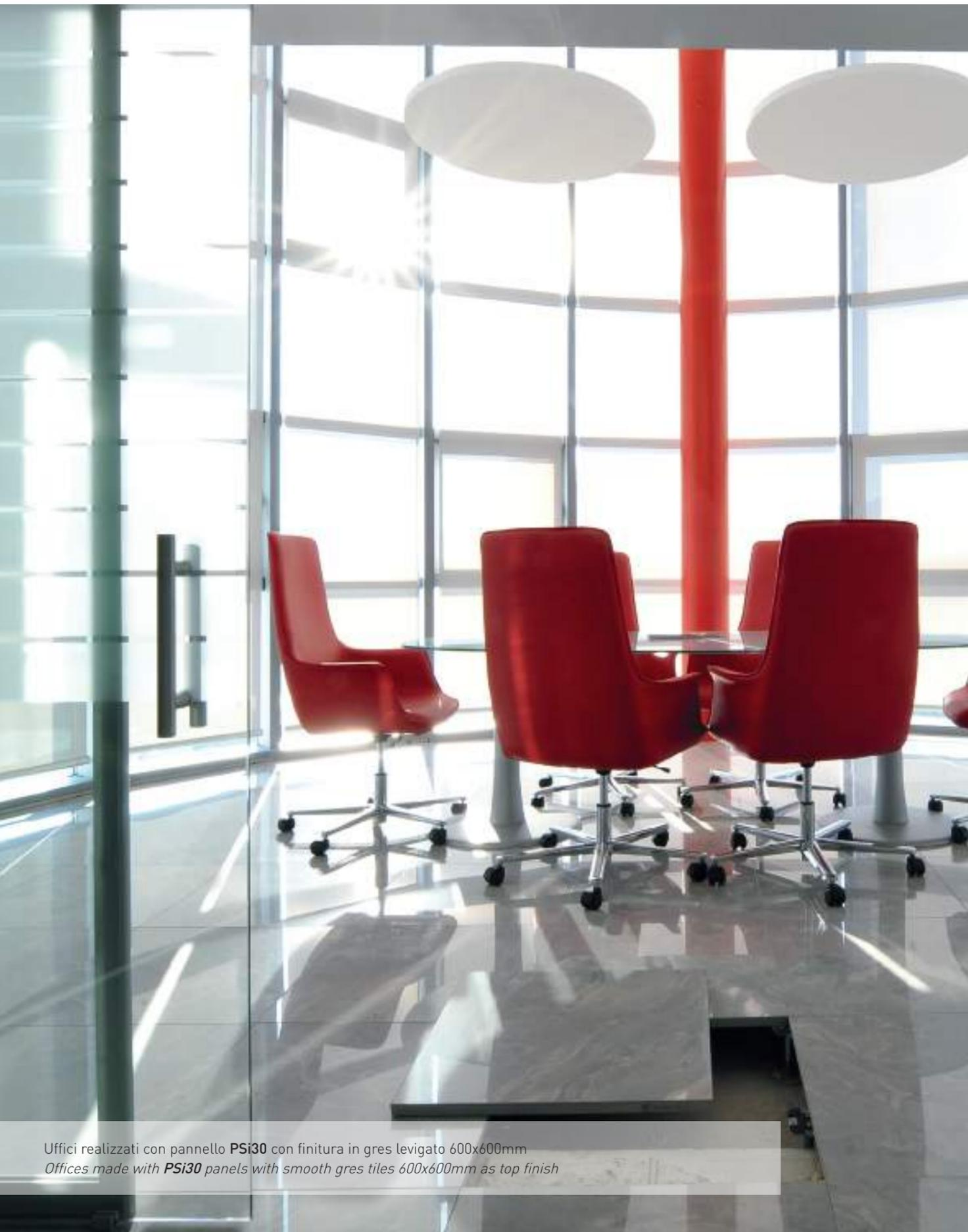
Uffici realizzati con pannello **PSi30** con finitura in gres levigato 600x600mm
