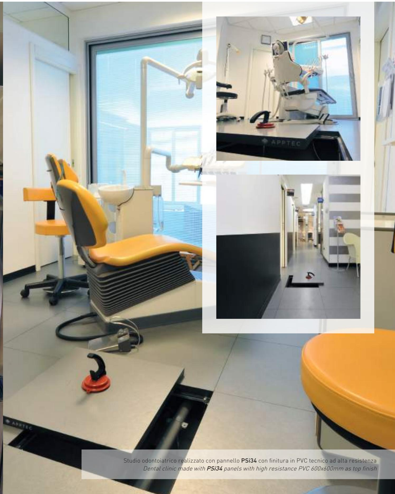
Studio odontoiatrico realizzato con pannello **PSi34** con finitura in PVC tecnico ad alta resistenza
